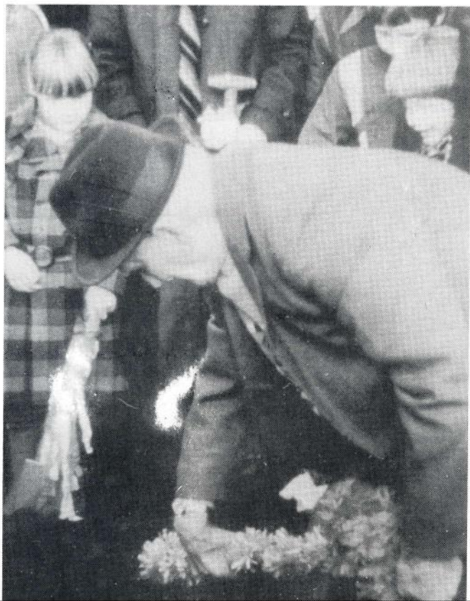
Aanzet tot nieuwbouw: opa Groenendijk zet de eerste spade in de grond.
